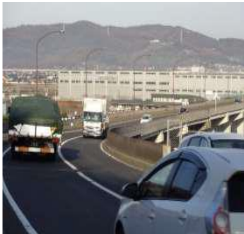
箕島矢部線下庄跨線橋の様子
