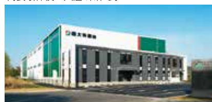
岡山物流センター
