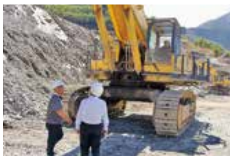
専門家の碎石現場の視察
