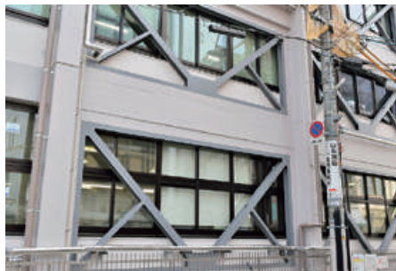
耐震補強を実施
