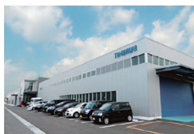
2019年5月に完成した新本社工場
