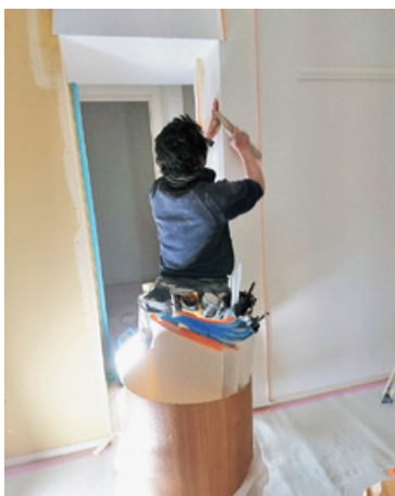
内装工事の様子
