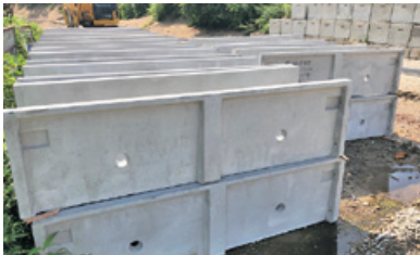
施工中の現場
