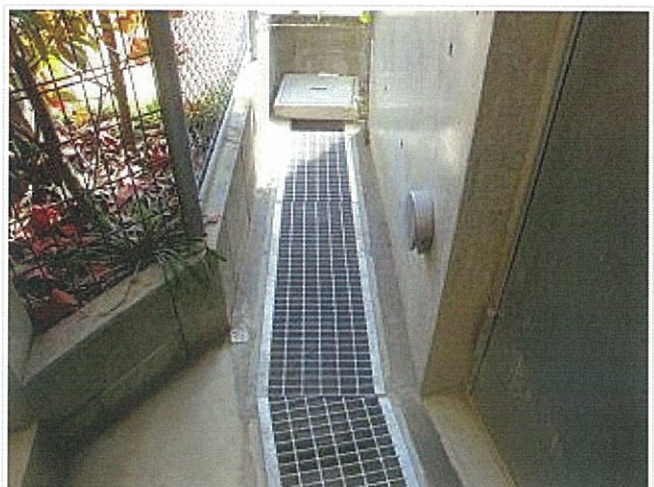
<一般土木工事>住宅横の側溝設置。 丁寧な仕事が好評です。
