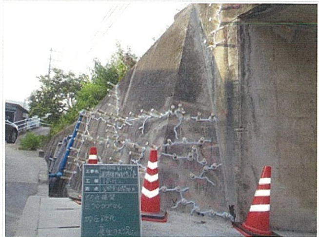
玉野市のBOXカルバート取合いもたれ擁壁に、クラック樹脂注入。
