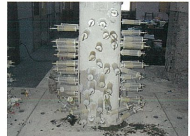
3 エポキシ樹脂低圧注入状況 ミクロカプセル 注入圧力 0.06N/mm 2
