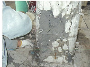
2 欠損部の修復状況 使用材料 IPH#600
