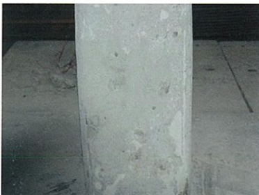
4 補修完了状況 表面研磨仕上げ
