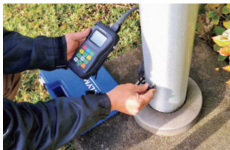
超音波厚さ計による鋼材の肉厚測定
