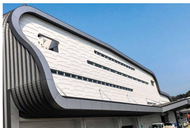
外壁金物を納入した、山陽新聞グループの早島印刷センター（岡山県早島町）
