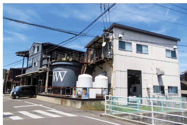
倉敷市児島の本社。水処理タンクがシンボルになっている
