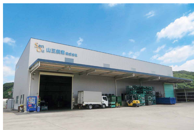
本社工場と道路を挟んで北側隣接地に、2020年に稼働した新工場
