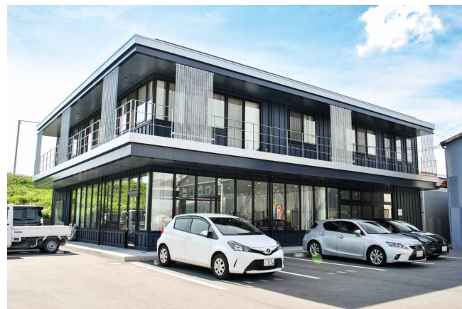
長船工場（瀬戸内市）の事務所は2023年に建て替え
