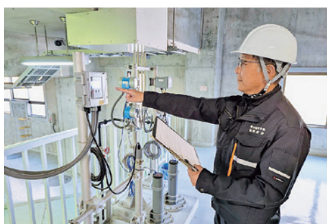
管理施設での作業の様子
