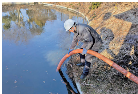
強力吸引車による池に溜まった泥の浚渫（しゅんせつ）作業
